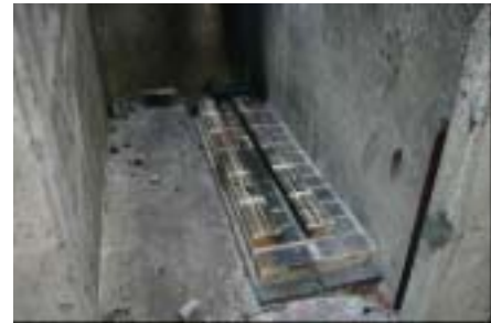
写真-1 模擬トンネル(土台部分)
