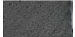
写真5 くつつくコンクリート切断面
