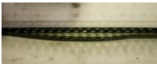
写真-2 17mm 金属板変形
