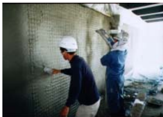
写真6 アルカリ骨材反応補修例
