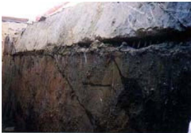
図6 側壁外部に生じた亀裂
