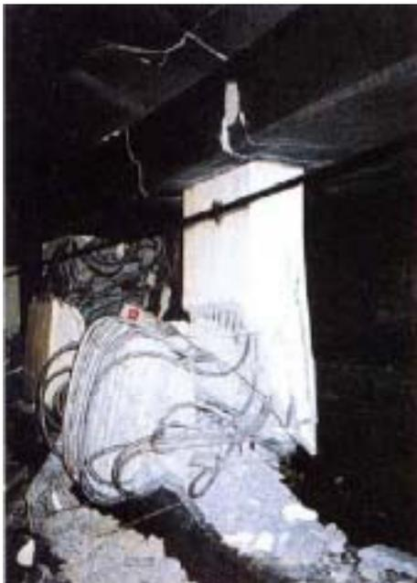
(1) 一方向に鉄筋が曲がる(中柱20)
