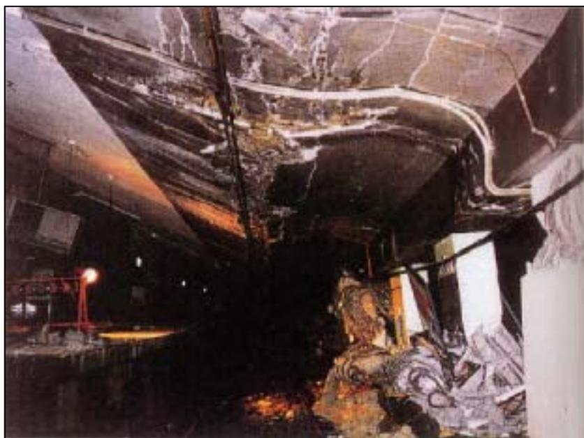
a) 中柱の脆性的破壊および上床版の沈下<sup>1)</sup>
