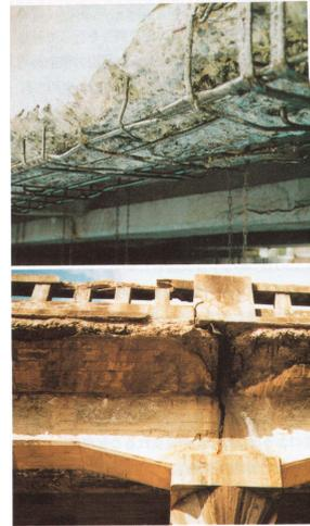
左:塩害で損傷したPC橋の主桁の外観
