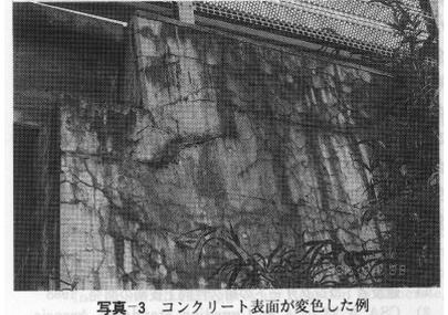
写真-3 コンクリート表面が変色した例
