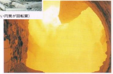
写真62 回転窯の内部
