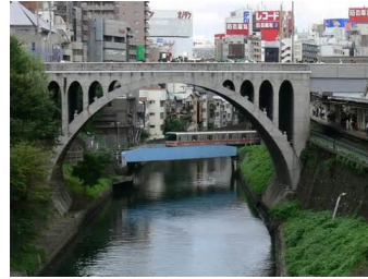
聖橋(ひじりばし) 1927年完成、御茶ノ水駅東端 鉄筋コンクリートアーチ橋
