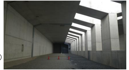
外環(国分工事) 工事中
