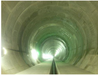
下水道 2011年竣工、横浜市港北区 港北処理区新羽末広線
