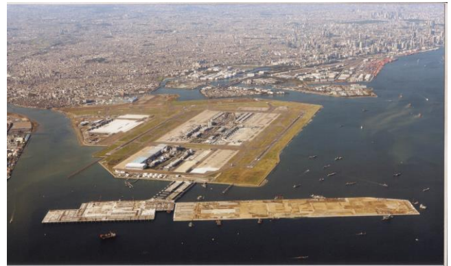
東京国際空港D滑走路建設外工事
