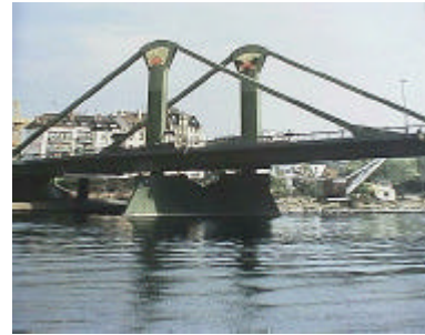
フレーザー橋、ドイツ、ヘッセン州 ・1986竣工 ・4径間連続PC斜張橋 橋長221m
