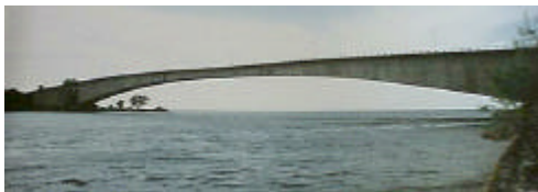
コロール・パベルタウ橋、パラオ共和国 ・1977竣工 中央ヒンジ付きプレストレストコンクリー 箱げた橋 両岸からのカンチレバー張り出し工法 橋長385.2m、幅員9.6m
