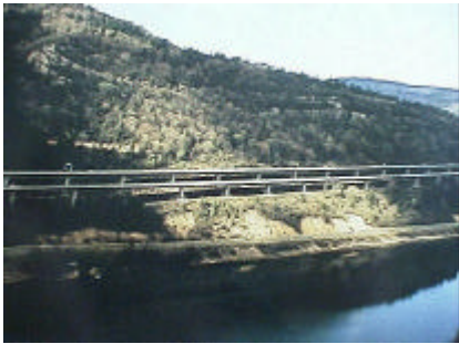
シラン高架橋、南フランス (フランス・スイスの国境付近) 高強度コンクリート(65 N/mm 2 )を用いたプレキャストセグメント 外ケーブル 橋長1266m、幅員 10.75m
