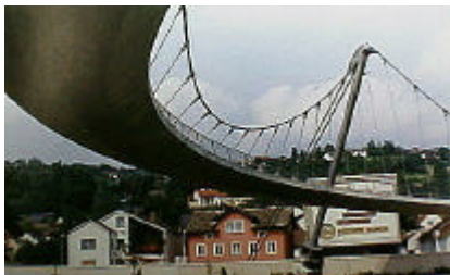
ケールハイム歩道橋、ドイツ、バイエルン州 ・1987完成 PC曲線吊橋 (片面吊り形式) 橋長約170m、幅員4.18m
