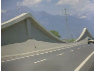
リト橋、スイス南西部 ・1987年完成 中央ヒンジ付き3径間連続下路橋 橋長256m、中央スパン143m
