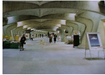
シュテューデルホーフェン駅 地下通路、スイス 構造部材の造形に注目
