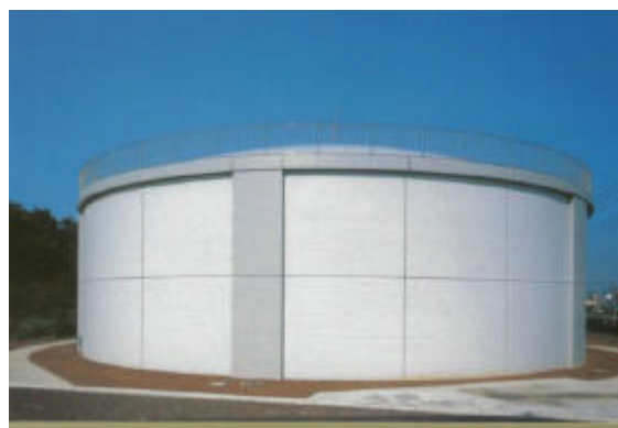
足利PCタンク(栃木県足利市)
