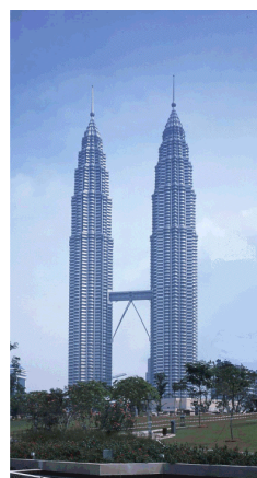
ペトロナスツインタワー (マレーシア) 規模 88階建て、高さ451.9m 実績 圧縮強度80N/mm 2
