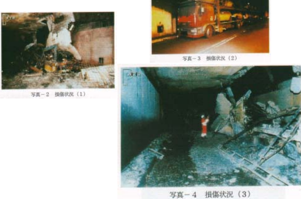
写真-2 損傷状況 (1) 写真-3 損傷状況 (2) 写真-4 損傷状況 (3)
