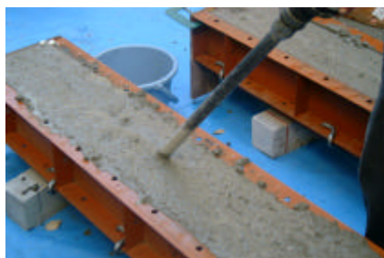
実際の締固め状況
