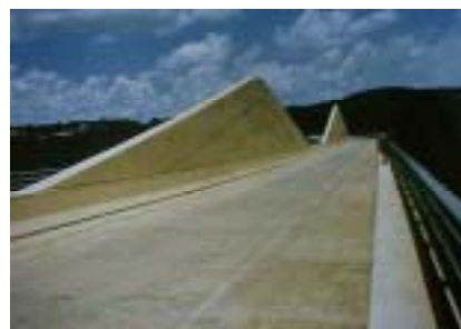
バートンクリーク橋 、アメリカ、テキサス州 ・フィンバック形式 ・3径間連続ラーメン橋 ・中央支間104m
