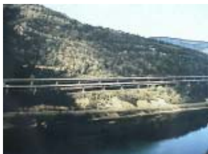
シラン高架橋 、南フランス(フランス・スイスの国境付近) ・高強度コンクリート(65 N/mm 2 )を用いたプレキャストセグメント ・外ケーブル ・橋長1266m、幅員10.75m
