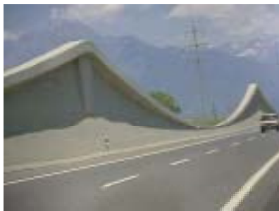
リド橋 、スイス南西部 ・1987年完成 ・中央ヒンジ付き3径間連続下路橋 ・橋長256m、中央スパン143m
