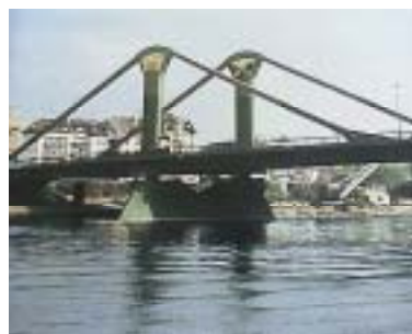
フレーザー橋 、ドイツ、ヘッセン州 ・1986竣工 ・4径間連続PC斜張橋 ・橋長221m
