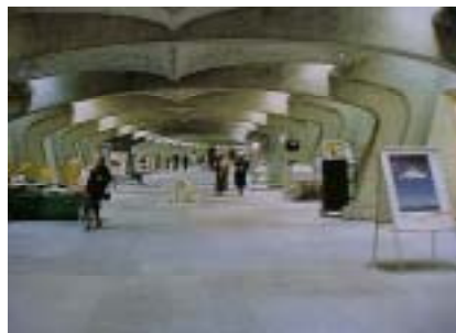
シュテューデルホーフェン駅 地下通路 、スイス ・構造部材の造形に注目
