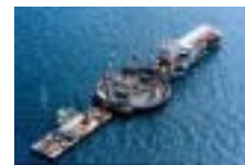
明石海峡大橋のケーソン
