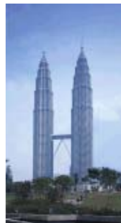
ペトロナスツインタワー (マレーシア)
