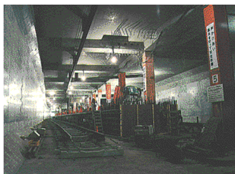
東急東横線 目黒駅 複々線化工事
