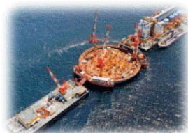
明石海峡大橋
