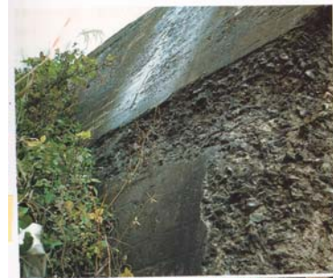
上:凍害を受けた機石 右:工場製の道路機石に 生じた凍害の事例
