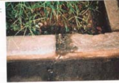
上:凍害を受けた機石 右:工場製の道路機石に 生じた凍害の事例
