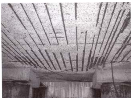
塩害で劣化した栈橋の床版 かぶりコンクリートが剥落し、鉄筋が露出している。 床版は桁に比べてかぶりが小さい場合が多く、広い範囲で剥落しやすい。
