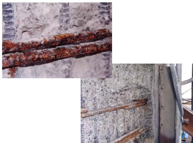
塩害で劣化した栈橋の床版 かぶりコンクリートが剥落し、鉄筋が露出している。 床版は桁に比べてかぶりが小さい場合が多く、広い範囲で剥落しやすい。
