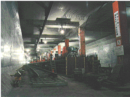
東急東横線 目黒駅 複々線化工事
