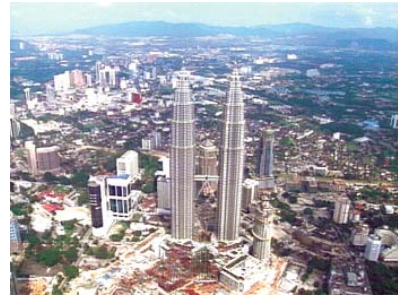
ペトロナスツインタワー クアラルンプール(マレーシア) 1997年 452m 88階立て 80N/mm 2 のコンクリートを使用
