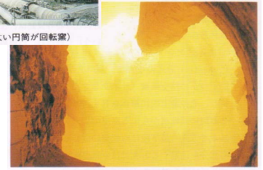
写真62 回転窯の内部
