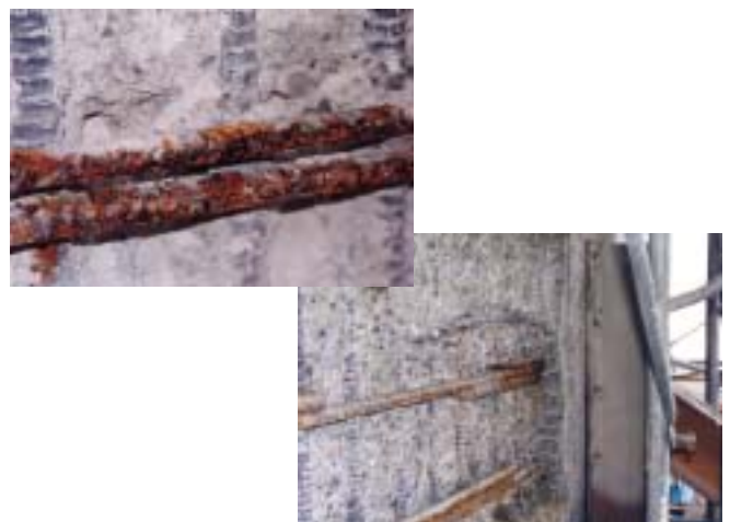
塩害で劣化した栈橋の床版 かぶりコンクリートが剥落し、鉄筋が露出している。 床版は桁に比べてかぶりが小さい場合が多く、広い範囲で剥落しやすい。
