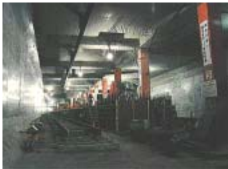
東急東横線 目黒駅 複々線化工事
