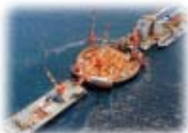
明石海峡大橋
