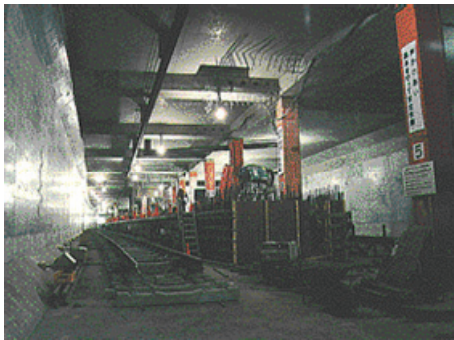
東急東横線 目黒駅 複々線化工事
