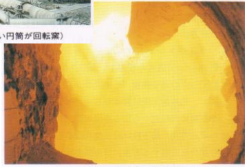
写真62 回転窯の内部
