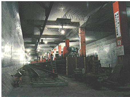
東急東横線 目黒駅 複々線化工事
