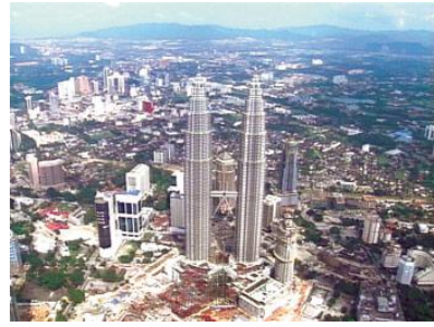
ペトロナスツインタワー クアラルンプール(マレーシア) 1997年 452m 88階立て 80N/mm 2 のコンクリートを使用
