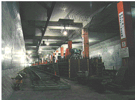
東急東横線 目黒駅 複々線化工事
