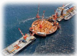
明石海峡大橋
