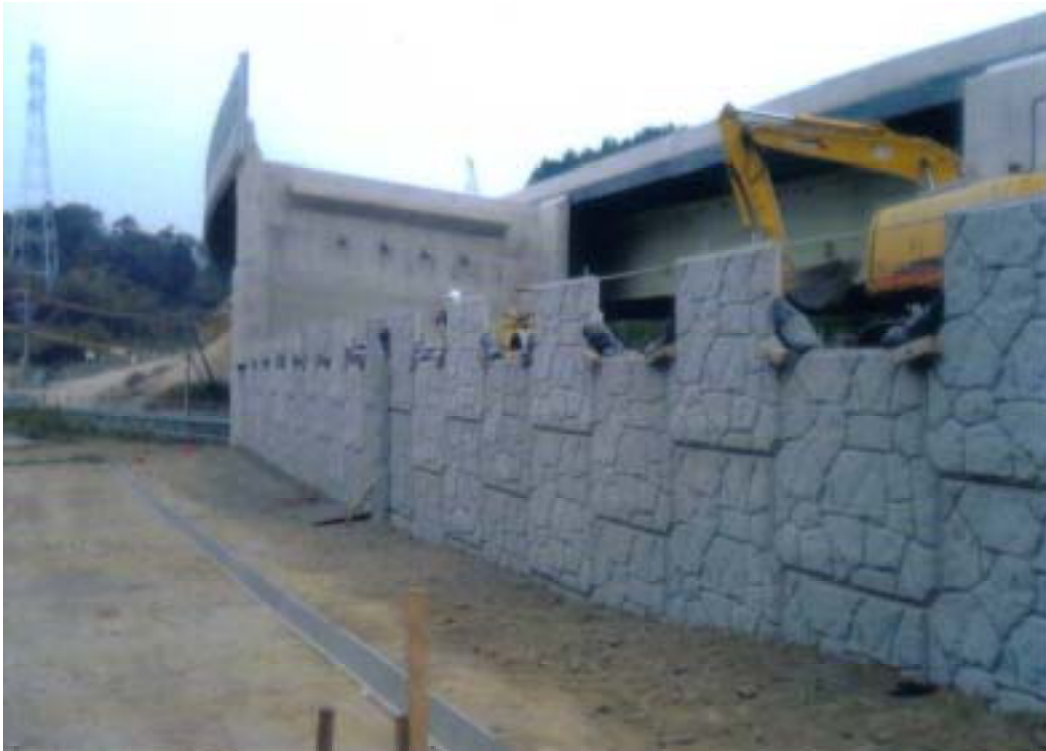
写真2 上:補強土工法に用いる化粧パネル(表面には石積み模様がデザインされている)
